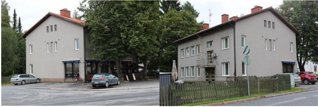
KUVAT: Entisen KOPin rakennuksen julkisivua
