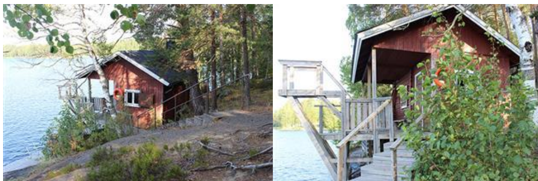
KUVAT: Rantasaunan julkisivuja
